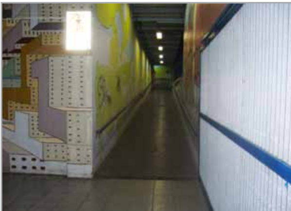
Come nelle altre stazioni della tratta, delle moderne rampe garantiscono l'accessibilità ai disabili
