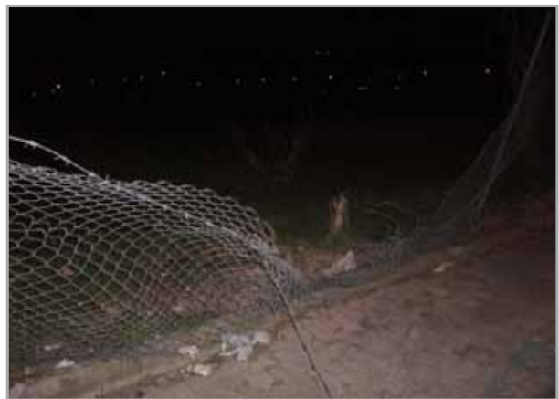
La rete di recinzione del parcheggio antistante, è stata divelta e non ripristinata
