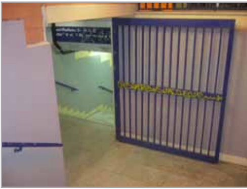
L'accesso al sottopassaggio è regolato da un cancello a chiusura manuale
