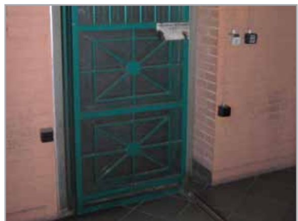
il cancello automatico per la chiusura notturna del complesso. Sulla destra si nota l'interruttore attivabile mediante chiavetta
