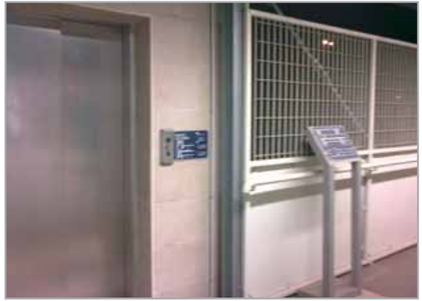
Uno degli ascensori disabili per l'accesso ai binari è guasto
