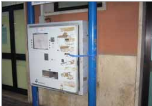
La biglietteria automatica è guasta
