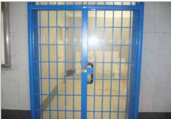
Sulla parete destra dell'atrio, l'ingresso di un locale in allestimento, probabilmente destinato a spazio commerciale. Analogie con la stazione Nuovo Salario, architettonicamente molto simile
