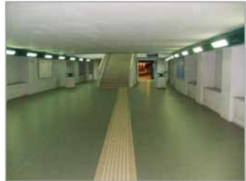
Ampio spazio interno al livello intermedio. La rampa conduce all'uscita su Via della Pineta Sacchetti, mentre il corridoio sullo sfondo conduce direttamente all'ingresso al Policlinico Gemelli
