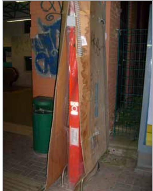
Le colonnine per le chiamate SOS, in allestimento in tutte le stazioni della tratta: qui, ancora imballate con del cartone, sono già state imbrattate
