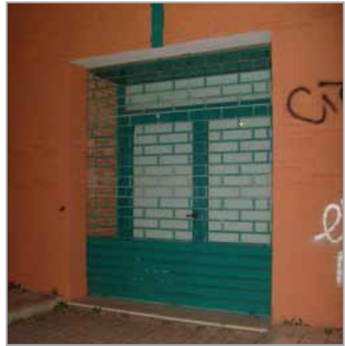
L'area adiacente al binario 1
