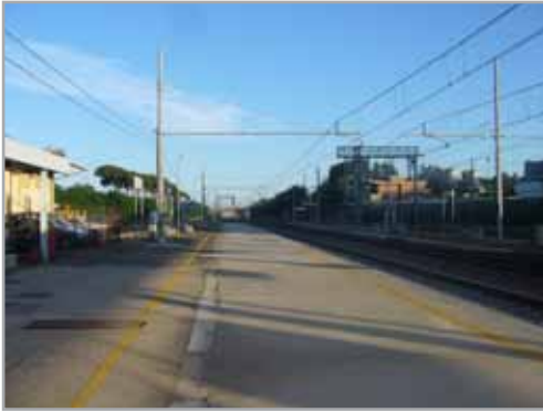
Il Binario 1 della stazione
