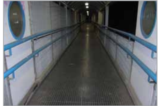
Le lunghe e moderne rampe, illuminate e coperte, consentono anche ai disabili, l'accesso ad entrambi i binari, grazie ad un passaggio sopraelevato che sovrasta i binari
