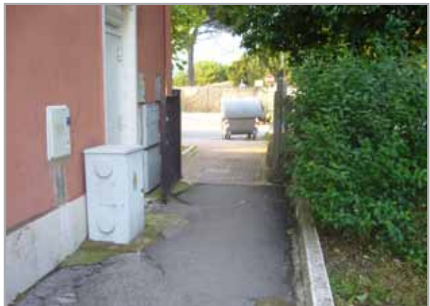
Un cancelletto d'accesso, molto basso, non sembra proteggere sufficientemente il plesso da intrusioni notturne
