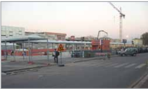
L'ingresso provvisorio della stazione, causa lavori in corso, visto dal viale antistante, sottostante la tangenziale
