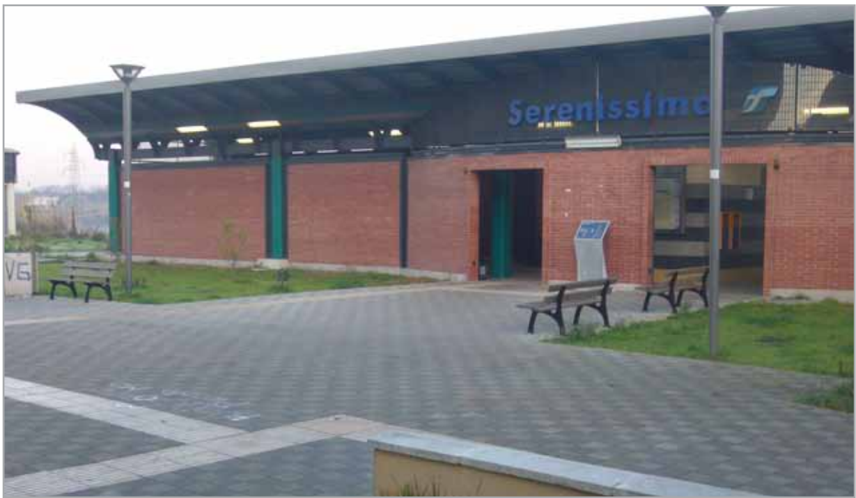
La stazione in prospettiva frontale
