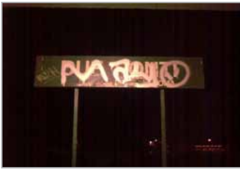
La cartellonistica, coperta da graffiti, rende incomprensibili le indicazioni. Il cartello con il nome della stazione, inoltre, per colori, struttura e caratteri, appare differente da tutti quelli delle altre stazioni.
