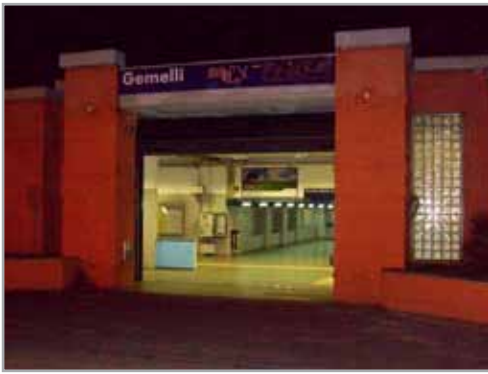
L'ingresso al piano inferiore della stazione affaccia su un parcheggio (sul lato opposto di Via della Pineta Sacchetti)
