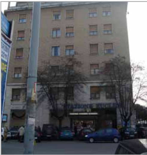
La stazione è situata sotto un caseggiato cittadino
