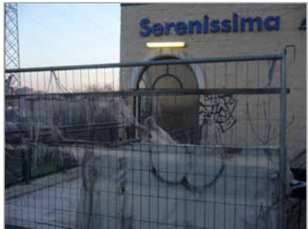
Il secondo "torrione" su Viale della Serenissima: inaccessibile per lavoro della Serenissima
