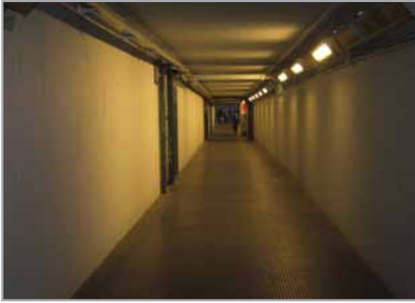
La lunga rampa di accesso ai binari per i disabili è completamente al buio
