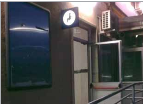
Rampe di accesso per disabili conducono agli uffici
