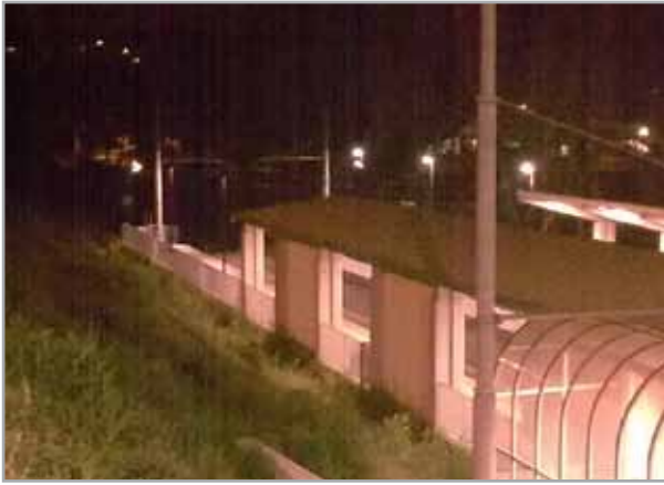
Veduta dell'area binari dalla strada
