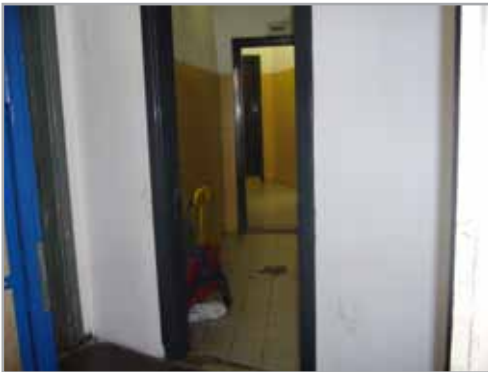
L'area adiacente al binario 1
