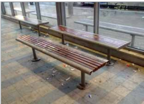
L'interno dell'edificio versa in uno stato di evidente degrado
