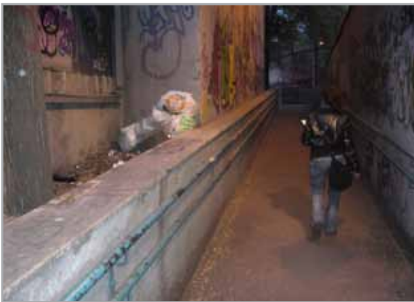
Lo stato di degrado della rampa di ingresso da Piazza Addis Abeba
