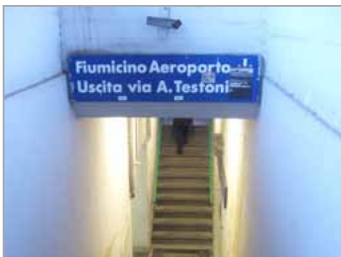
Scala di accesso al sottopassaggio per l'attraversamento dei binari
